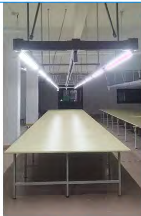
吊顶母线槽
